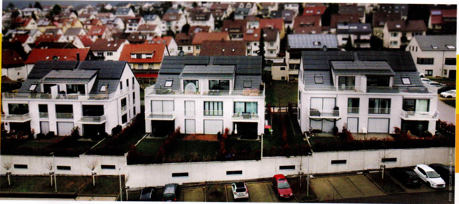
Die drei Mehrfamilienhäuser in Altbach bei Stuttgart werden jeweils über eine PVT-Wärmepumpen-Anlage mit Wärme versorgt. Pro Haus besteht diese aus 36 PVT-Kollektoren mit einer Gesamtfläche von je 71 Quadratmetern und zwei Wärmepumpen mit je 14 kW Leistung.
