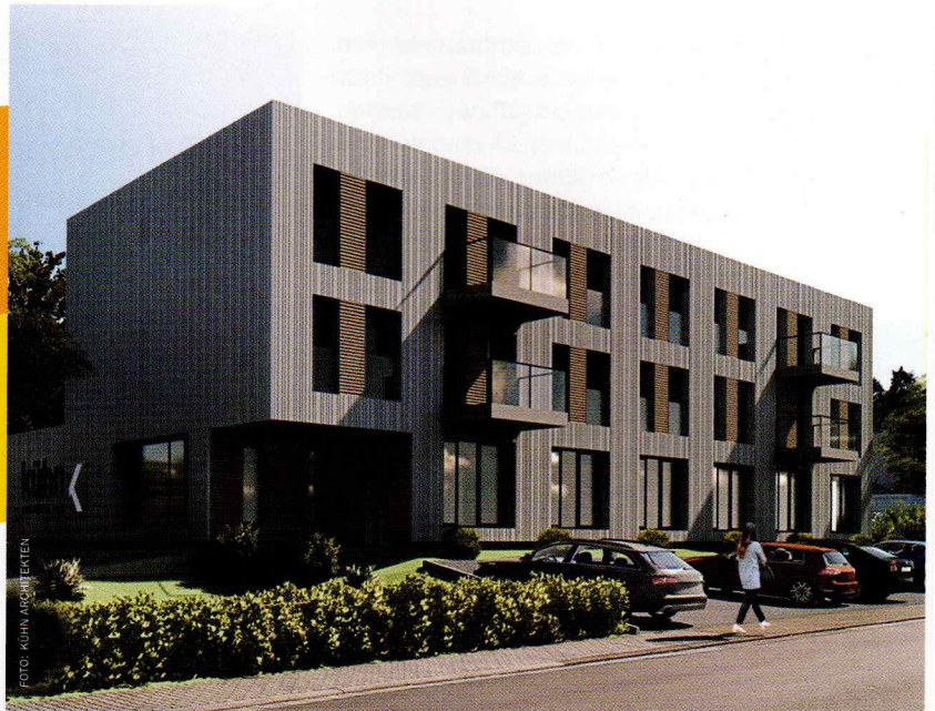
Mischgebäude im saarländischen Eppelborn: Vier Wohnungen und ein Büro auf einer Gesamtfläche von 900 Quadratmetern werden über 75 PVT-Kollektoren und zwei 17-kW-Wärmepumpen mit Heizwärme und Warmwasser versorgt.
